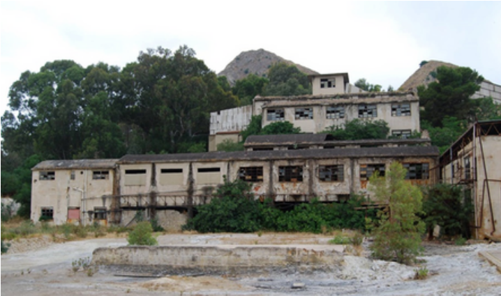
Impianto di flottazione ancora da restaurare
